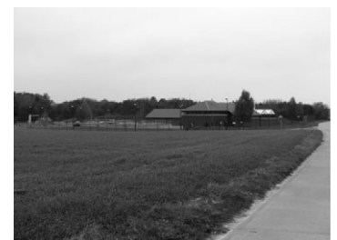
Station d'épuration des eaux usées domestiques
