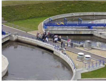
Visite guidée de la station d'épuration AIDE
