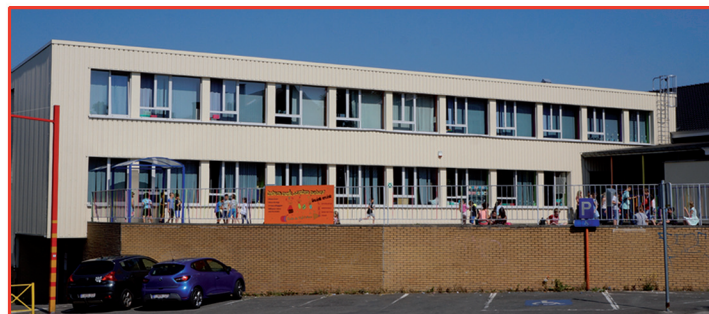
Centre éducatif du Val d'Aaz Rue du Ponçay, 1
