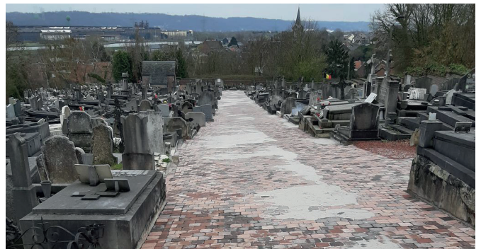
L'allée principale du cimetière de Vivegnis réalisée en klinkers
