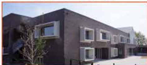
EFC Houtain Voie du Puits, 13 04/353 38 10
