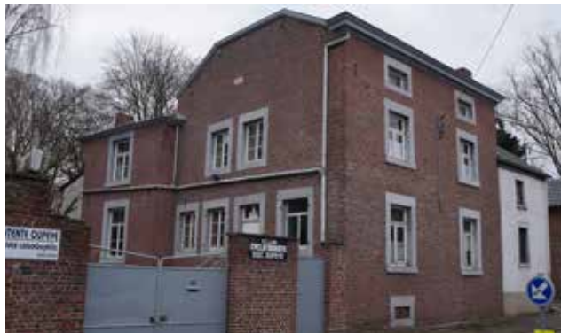
Bâtiment communal rue Sondeville
