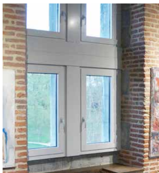
Nouveaux châssis dans la Tour du Château et nouvelle chaudière à la piscine de Haccourt.
