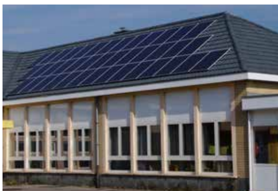
Panneaux photovoltaïques à l'école...
