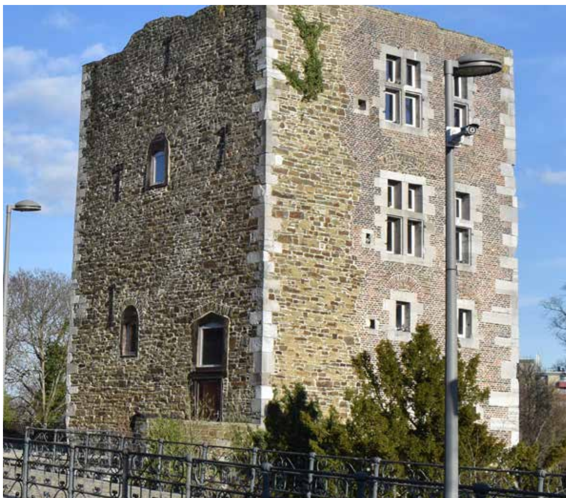
Nouveaux châssis double vitrage sur la Tour du Château.
