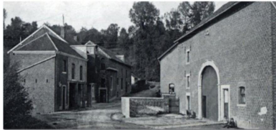
Ce dernier est encore appelé Moulin Frenay ou Moulin Defize du nom des anciens propriétaires. Les bâtiments furent construits vers 1860, mais leur origine remonterait à des temps plus lointains. La roue à augets, est située derrière le bâtiment et était alimentée par un petit affluent de l'Aaz, ruisseau qui passe sous la demeure. Ce moulin avait la particularité de fonctionner à l'énergie hydraulique et électrique.
